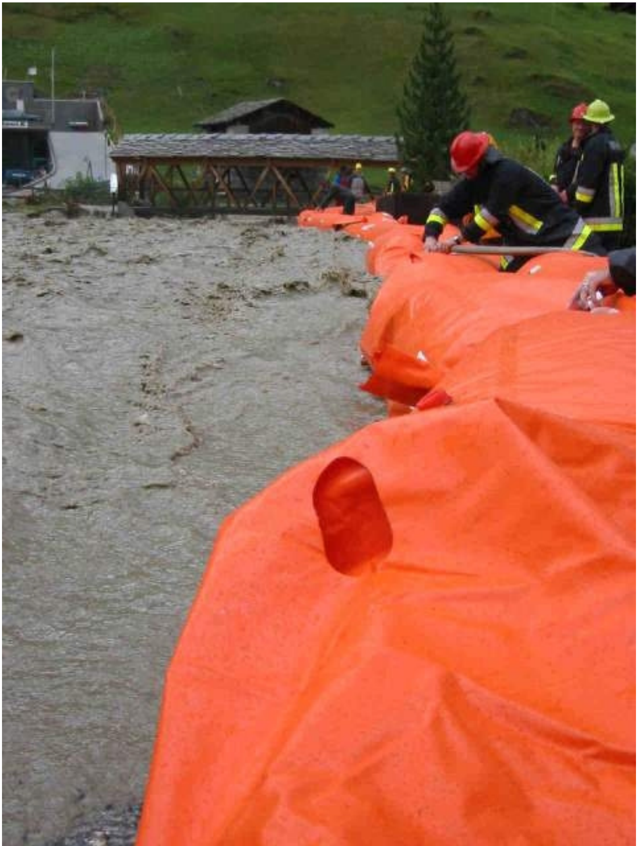
Aufbau des Beaver Schlauchdammes unter extremsten Bedingungen
