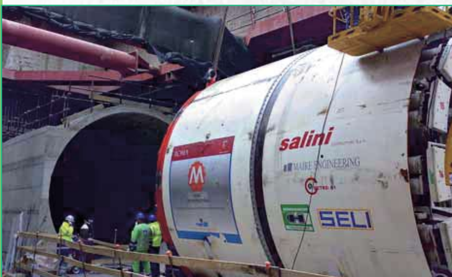
Metro Rome TBM Tunnel - Италия
