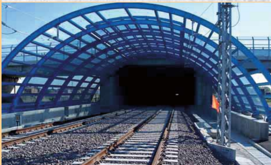
Fontanellato Tunnel - Италия
